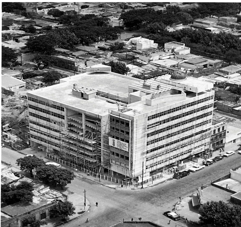
Figura 8. Principal inmueble en construcción 1969
