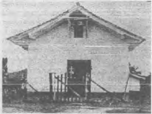
Aspecto de la capilla antes de la intervención de 1959. 10
